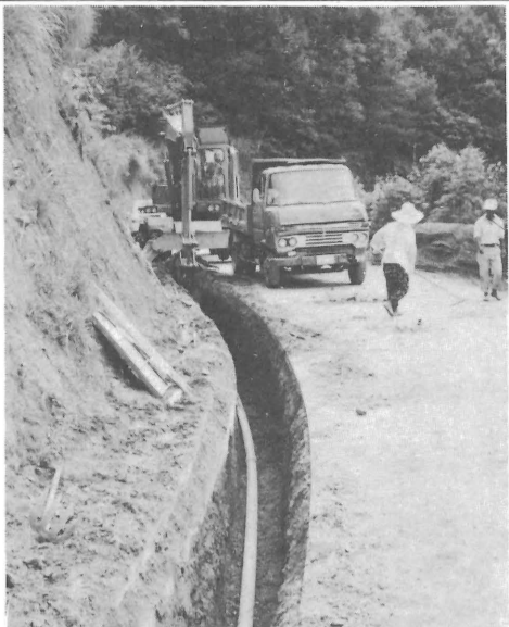
送水管布設工事 予子林工区 (大駄馬附近)
