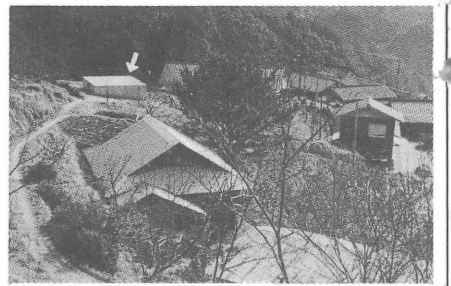
できあがった防火水槽
