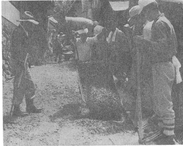
役場職員による舗装工事
