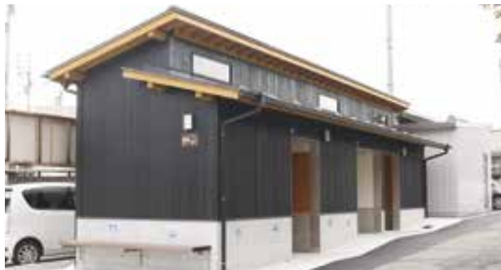
木造平屋建て 29.81㎡
