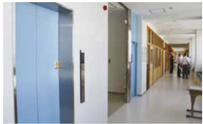
車いすにも対応できるエレベータ設置
