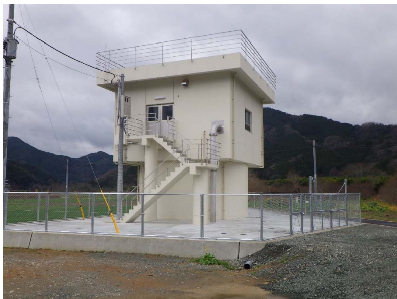
大洲市上水道 村島水源地
