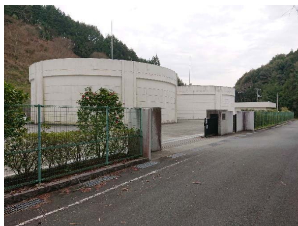
大洲市上水道 五郎配水池
