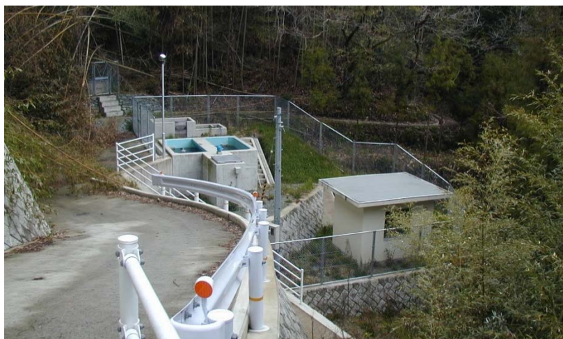
中央簡易水道 上中野浄水場
