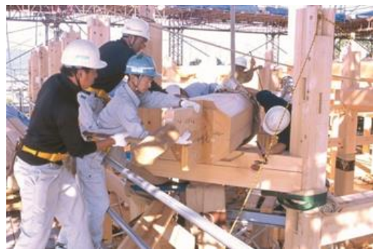
▲天守閣復元事業 建て方工事の様子
