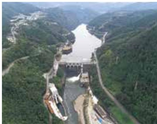
鹿野川ダムは昭和34(1959)年3月に竣工し、肱川の治水(洪水調節)およびクリーンなエネルギー供給(水力発電)を行ってきました。また、全国に先駆けてダム再生事業を実施し、トンネル洪水吐など、すべての事業が本年完成しました。
