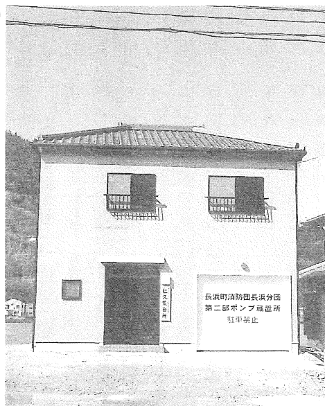
完成した仁久集会所(2階部分)・消防詰所
