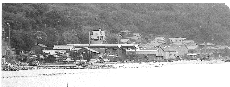
築堤工事が進む仁久地区
