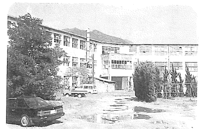
旧長浜中学校を解体 (6.11.17)
