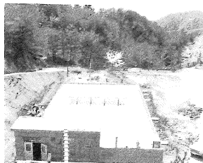
戒川小学校プール完成 (47・3・31)
