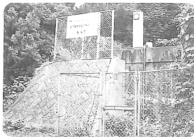
下須戒・大久保簡易水道施設完成 (62.11.30)
