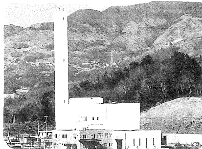
大洲市・長浜町環境センター完成 (3.3.21)
