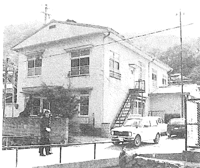
櫛生隣保館完成(40・12・25)
