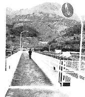
大和橋歩道橋完成(48・3・28)
