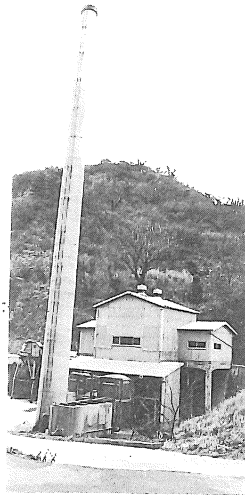
大型ゴミ焼却場 (日量20 トン)改築 (46・4・26)
