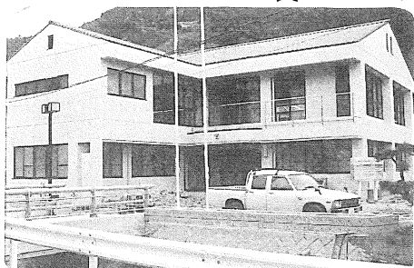
櫛生福祉センター完成 (63.3.10)
