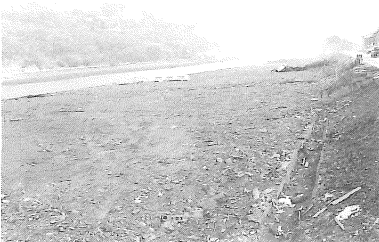
4年度完成に向け整備が進む小浦リバーサイドスポーツパーク(注解・8ページ)
