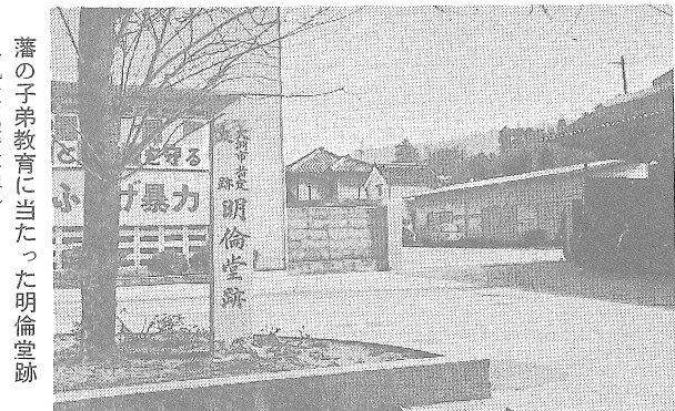
大洲警察署に当たった明倫堂跡 (現大洲警察署)
