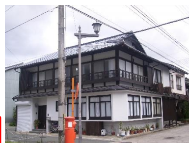
補助制度による改修事例
