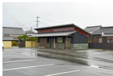
長浜大橋のたもとに整備した駐車場と休憩所
