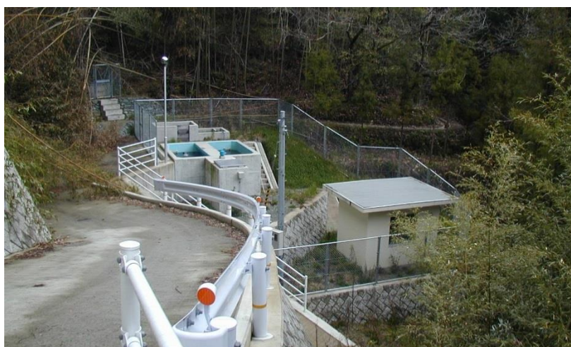
中央簡易水道 上中野浄水場
