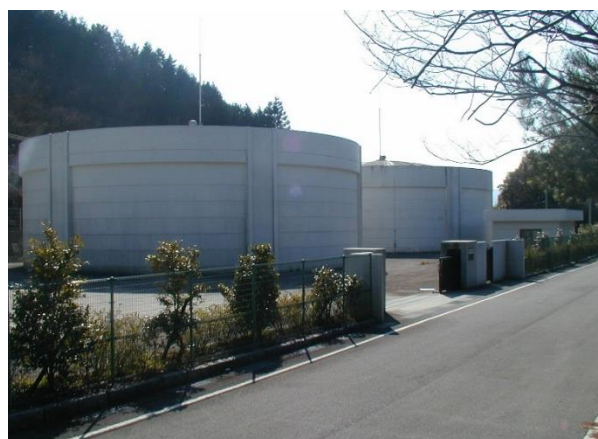
大洲市上水道 五郎配水池
