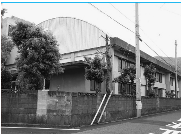
改築される長浜小学校屋内運動場
