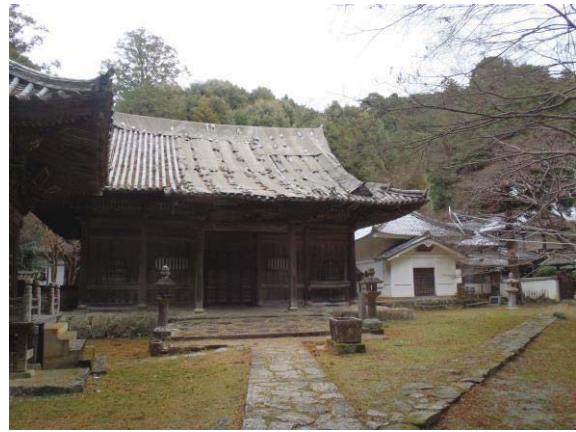
屋根にシートが掛けられた如法寺仏殿
