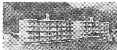
大和団地2棟目(16戸)完成 (58・2・23)
