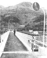
大和橋歩道橋完成(48・3・28)
