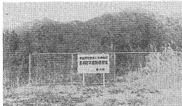
峯大越不燃物処理施設事業に着手 (59年度完成)
