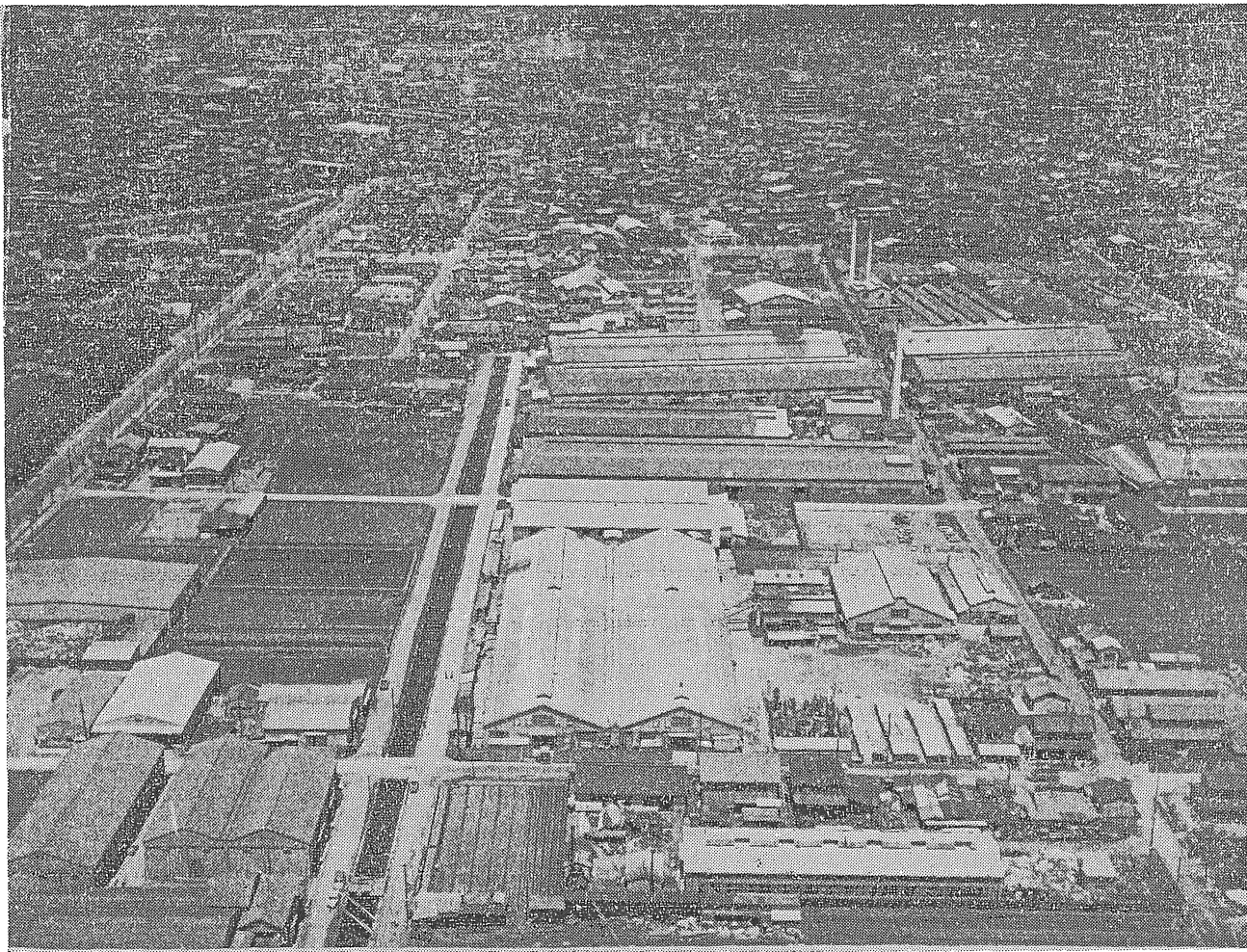
福 山 ゴ ム 工 業 株 式 会 社 工 場 全 景
