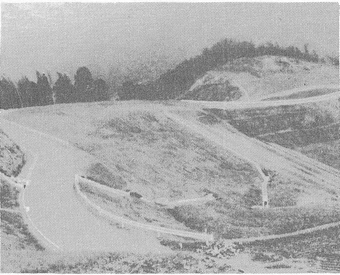
幹線道路と造成地の一部
