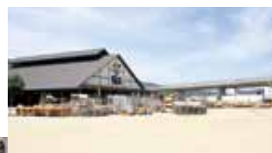
災害発生4日後
