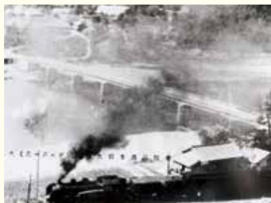
大和橋（長浜）と鉄道
