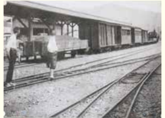
伊予大洲駅線路内
