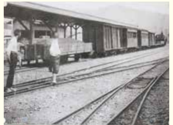
伊予大洲駅線路内
