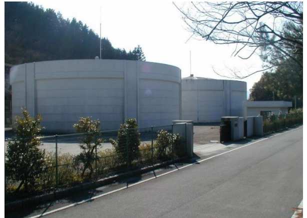
大洲市上水道 五郎配水池
