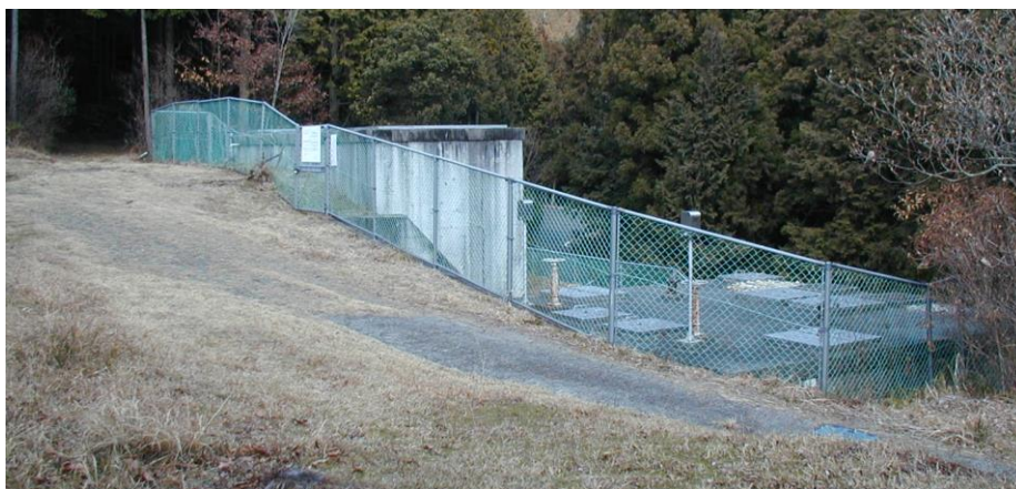
保子野簡易水道 浄水場
