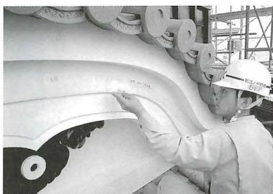
天守三層に載る唐破風は最も苦労した部分。唐破風の曲線を造り出すために型板を作成した。
