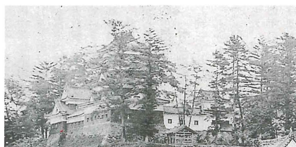
▲明治時代の写真に写る高欄櫓 元禄絵図に描かれている下見板は取りのけられている。
