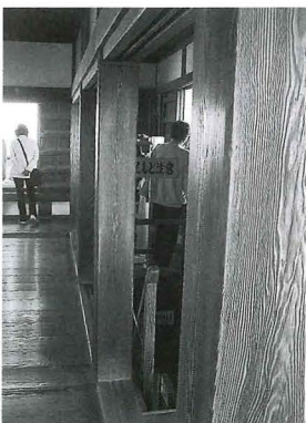
▲松山城天守最上階(3階)の柱 鉋で美しく仕上げられている。
