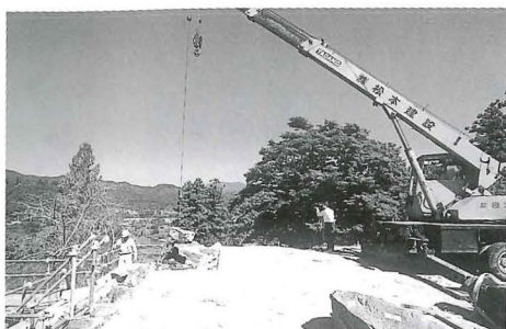
▲石垣解体の様子。石の撤去はクレーンを用いて行った
