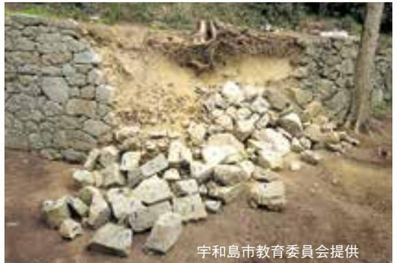
根によって石垣が崩落した例（宇和島城跡）
