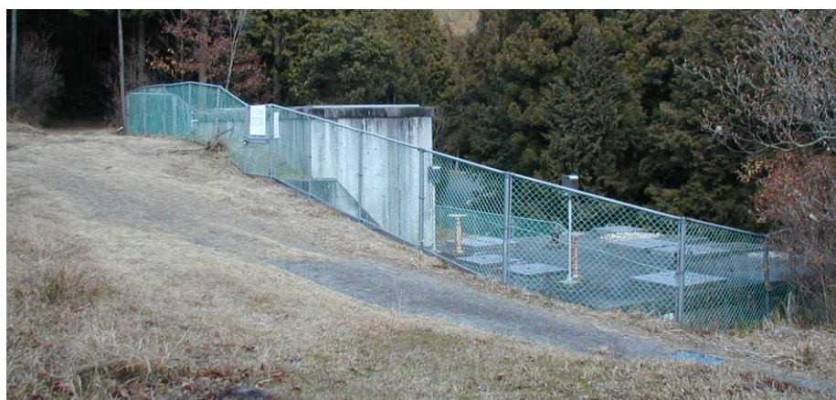
保子野簡易水道 浄水場
