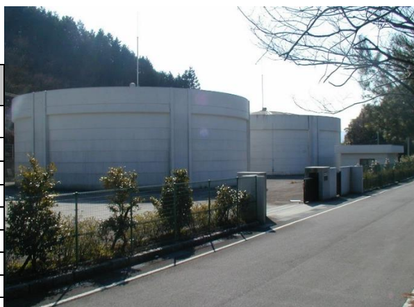
大洲市上水道 五郎配水池
