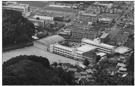
耐震化が進められる大洲北中学校
