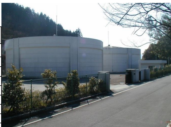
大洲市上水道 五郎配水池
