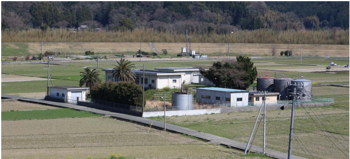
大洲市柴浄水場
