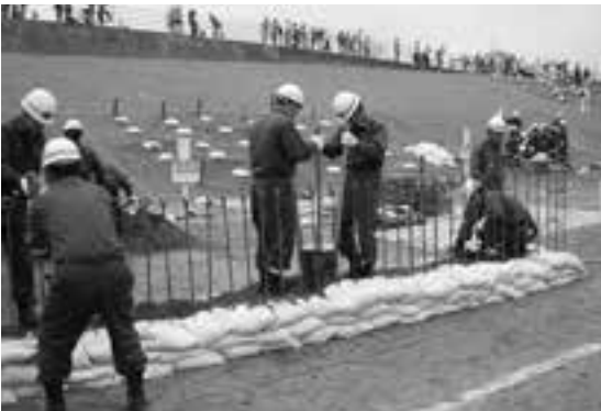
積み土のう工
