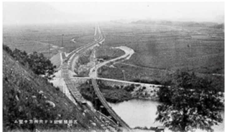
昭和9年の路線改修工事（五郎駅付近）
