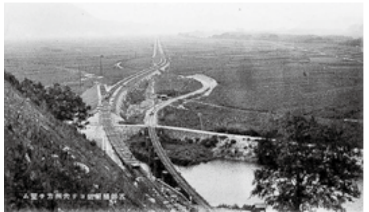
昭和9年の路線改修工事（五郎駅付近）
