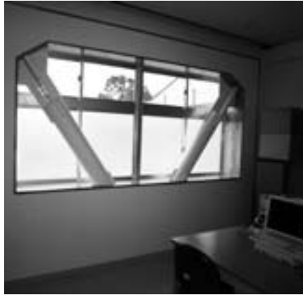
耐震補強工事が完了した菅田小学校
