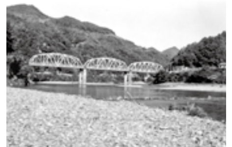
トラス橋の旧鳥首橋
