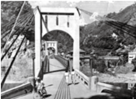
吊り橋の旧鹿野川大橋
