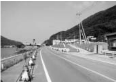
工事が進められている上老松地区の水防災事業
