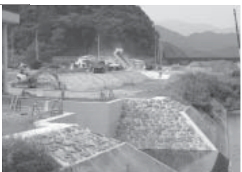
急ピッチで進む久米川改修工事
