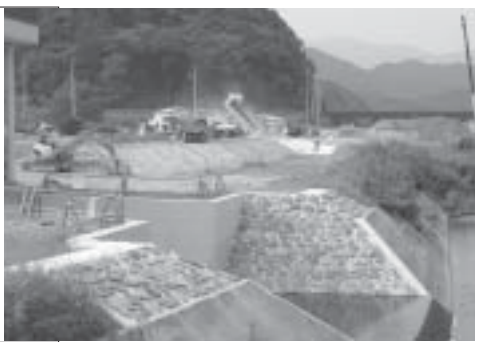
急ピッチで進む久米川改修工事
