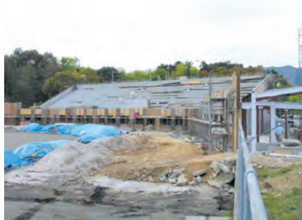
急ピッチで進む運動公園野球場改修工事。
