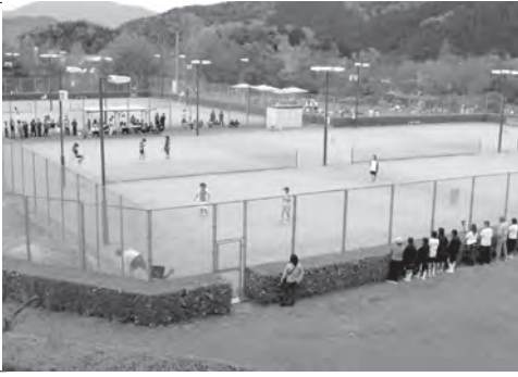
八幡浜・大洲地区運動公園 テニスコート
