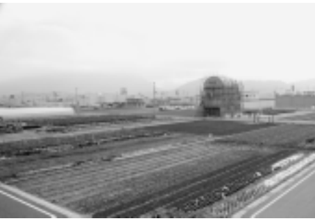
図書館移転建設地となる東若宮地区
