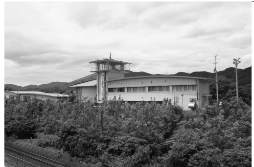
防災センター
