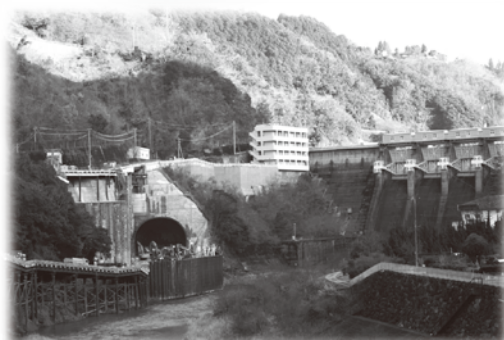
鹿野川ダム・洪水吐工事
