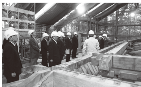
▼厚生文教委員会 国指定重要文化財「如法 寺仏殿」保存修理事業 (柚木)
