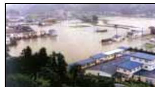
肱川の氾濫による水没写真
