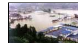
肱川の氾濫による水没写真
