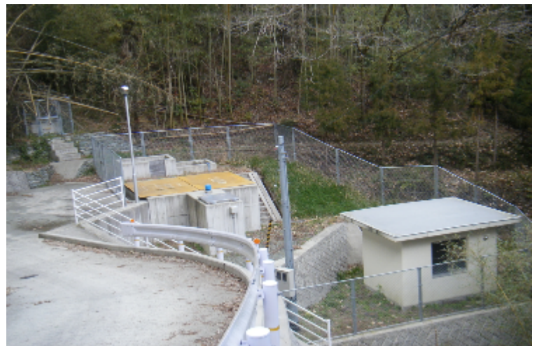
中央簡易水道上中野浄水場
